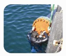
(10) Colocação de um manômetro e de uma válvula com a ajuda de um mergulhador. Introduzir pressão até igualar a da água.
