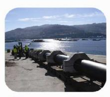
(6) Lançamento ao mar das secções de 65 m que se unem por soldadura, até formar comprimentos de 325 m.
