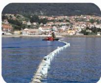
(9) União de ambas as secções de tubagem com ajuda de flanges colocadas nos extremos e colocação de bóias para facilitar a manobra de afundamento.
