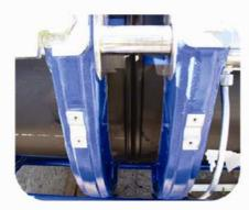
(2) União dos tubos por soldadura em secções de 65 m (duração aproximada = 1,5 hr./soldadura).
