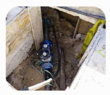
(11) A injeção de água potável controla-se desde terra (abrindo as válvulas). Equilibradas as pressões injeta-se água na tubagem de forma que esta retire todo o ar do seu interior através das válvulas.
