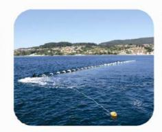
(12) O enchimento da tubagem com água potável faz com que esta se afunde ate sair todo o ar através das válvulas, este afundamento deve ser o mais progressivo possível de forma a não deformar a tubagem nem as uniões soldadas.
